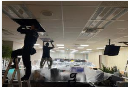
冰水主機設備汰舊換新
